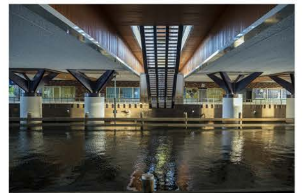
Station Utrecht Vaartsche Rijn Hoge kwaliteit afwerking van de viaducten maakt van de onderdoorgangen een stedelijk interieur.
