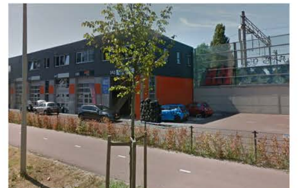
Waldorpstraat, Den Haag Gebouwen direct aan (en deels onder) het spoor maken adressen en bestemmingen aan de Horvathweg.
