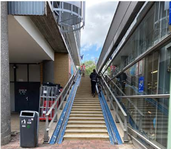
Een trap, verscholen tussen het AMEC gebouw en het Horvathviaduct, verbindt de fietsenstalling van het station met de fietsroutes in de oost-west richting.
